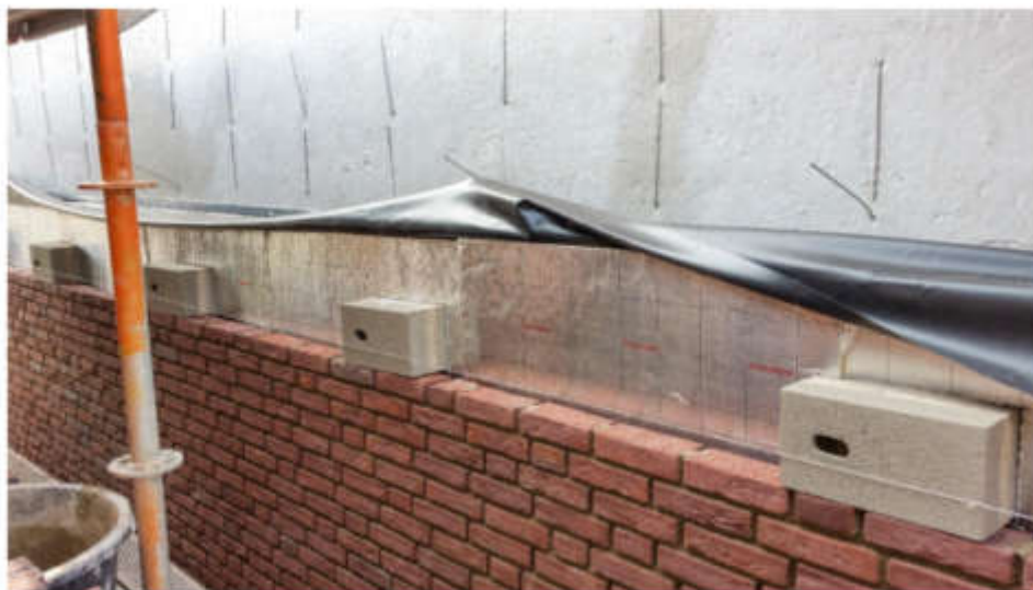
Gierwaluwkasten (van Vivara Pro) worden ingemetseld in een muur met isolatie (Bron: Vivara Pro)
