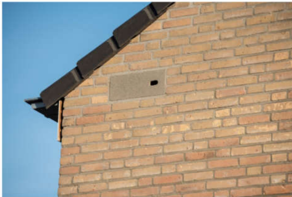
Inbouwkast van gierwaluw verwerkt in de kopgevel van een woning (Bron: Vivara Pro)
